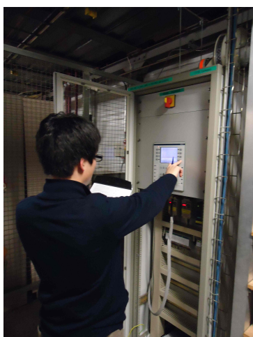
図2 シフトの作業の様子。検出器に供給しているガスの流量が正常であるか確認している。
